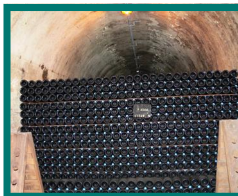
A34 Stockage des bouteilles sur lattes-MG
