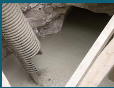
Phase 4: Remplissage avec un coulis adapté ré-excavable par nappes successives après prises de celles-ci
