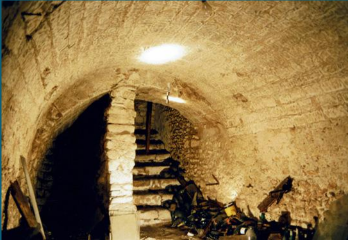
C202 « Flambage » d'un poteau sous dimensionné – PHT
