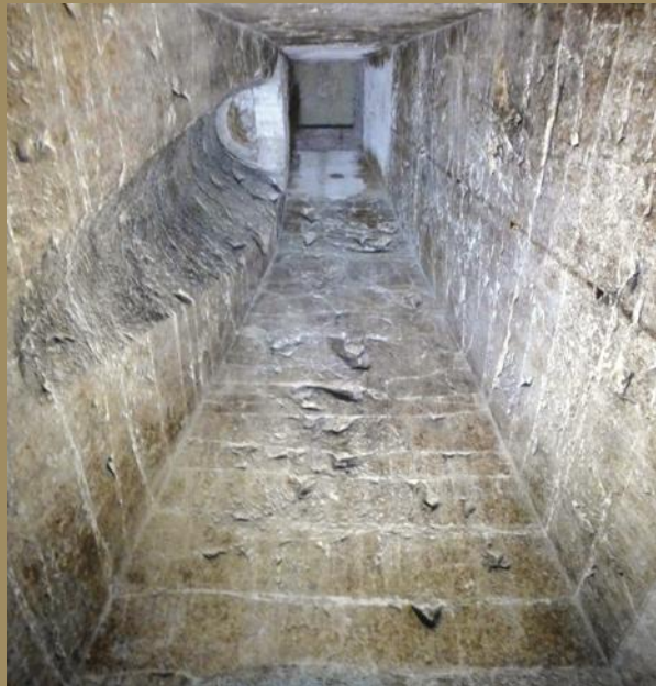
B157Bis Joints horizontaux de bancs bien visibles dans un essor - PHT
