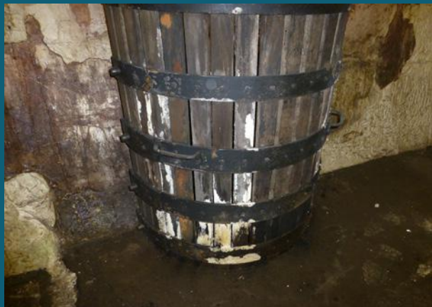
C222 contamination par la mérule - PHT
