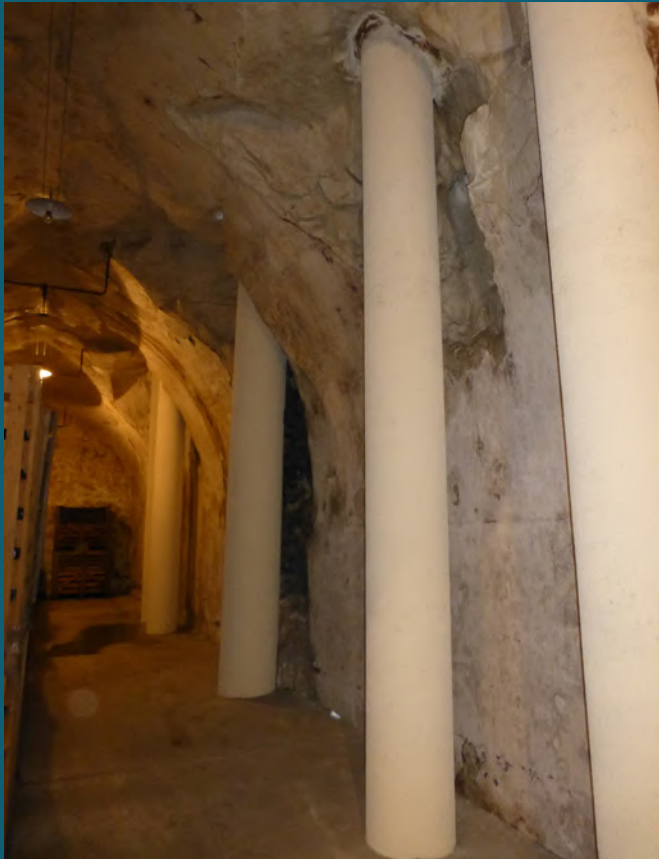
C190 Pieux modernes de fondations profondes dans une cave - PHT
