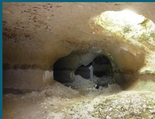
C197 C198 Venue à jour d'un fontis vue du dessus et du dessous - PHT
