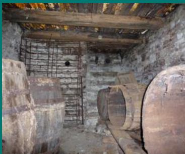
A128 A129 Bars-su- Aube - Effets du manque d'aération des caves et de la condamnation des accès: moisissures et affaissements - PHT
