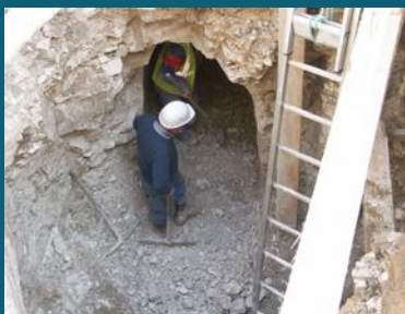
Phase 3: Purgé des sols d'assise du remplissage et construction des murs masques
