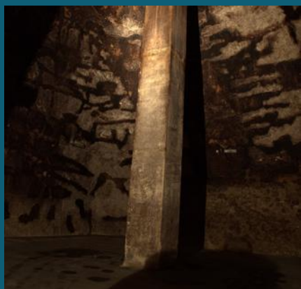
C176 Pilier en béton armé - MG
