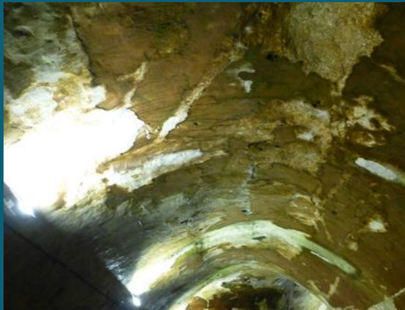
C257 C258 L'éclairage direct des parois avec une lumière intense favorise la prolifération des algues vertes en périphérie du halo - PHT
