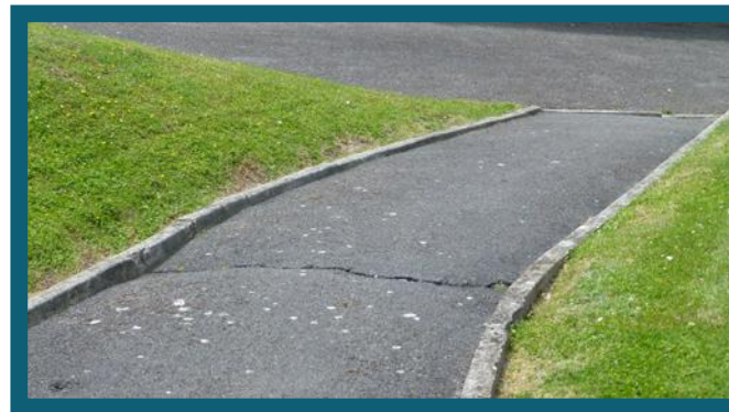
168bis/ter : Exemple de désordres propices à l'humidité
