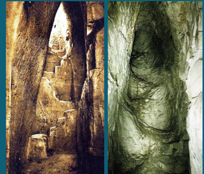
C243 C244 Abandon d'un ancien escalier de carrier - PHT
