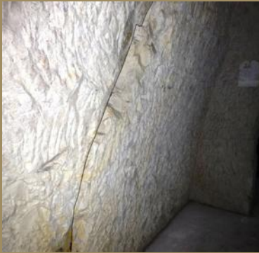
B153 B154 Discontinuités plus ou moins verticales : les diaclases - PHT
