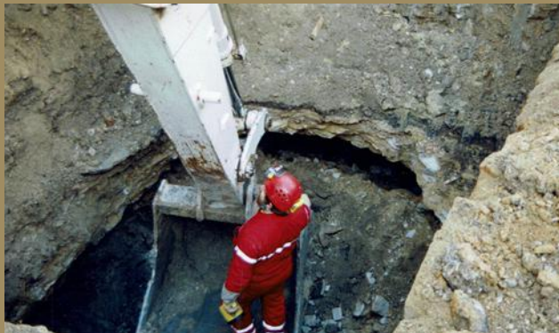
B150 B151 B152 Exemples de puits fondés à la main pour la recherche d'une cavité située à 16 m de profondeur sous un ouvrage existant - PHT
