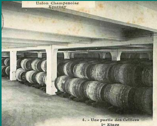
A119 Celliers en béton armé à Epernay - ADM/FI
