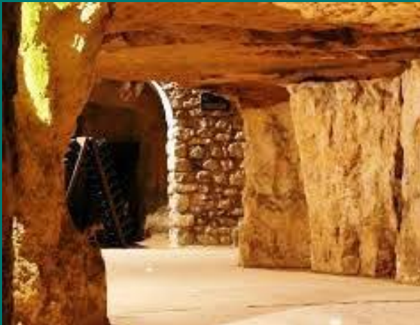
A93 Carrières/caves viticoles creusées dans le calcaire à Fleury-la-Rivière (51) - PHT - Le souterrain est à la fois une carrière et une cave.
