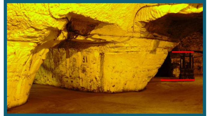
C209 C210 Cas préoccupants : chutes de blocs suite à l'usure mécanique du passage des palettes - PHT
