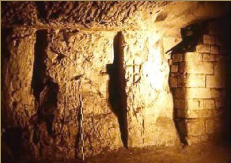
B1582 Dépilage d'un pilier abandonné pour ne pas affaiblir la zone porteuse des ouvrages de surface - PHT
