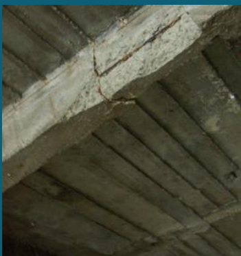
C213 Le sous-dimensionnement des ouvrages - PHT
