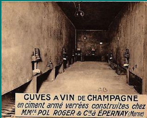
A120 Caves en ciment armé - ADM/FI
