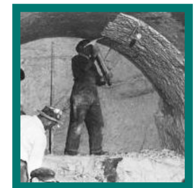
A322 Finition du parement de la galerie.
