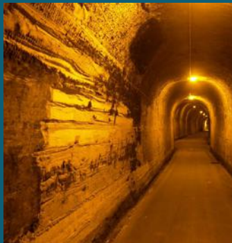
C206 C207 C208 Usure des parois par le passage des palettes - PHT
