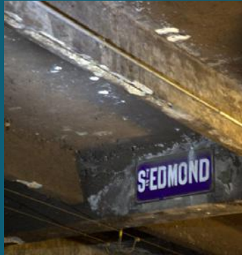
C211 C212 Exemples d'altérations dues à la carbonatation - PHT MG
