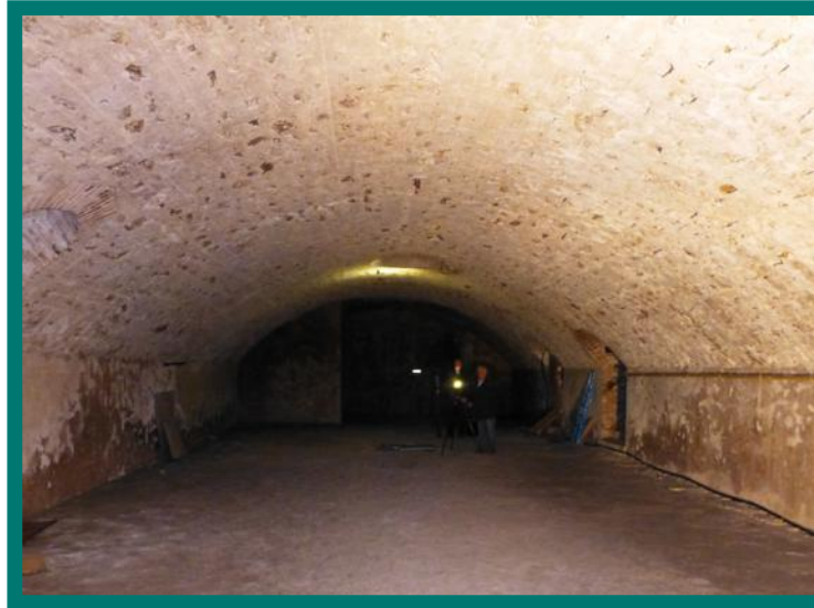
A46 Epernay : voûte maçonnée en berceau segmentaire (caves inutilisées) - PHT
