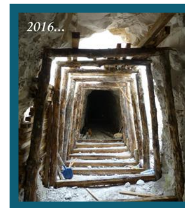
Restitution des boisages des galeries souterraines du fort de 1917 - PHT
