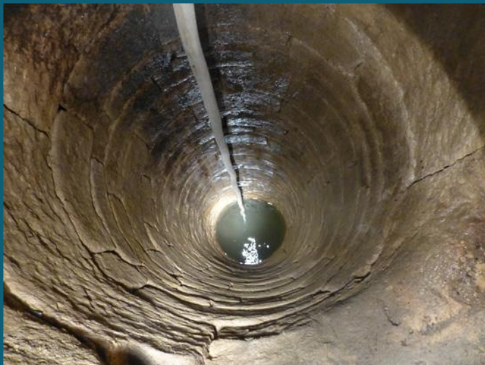
C2312 Les puits permettent d'observer directement les variations des niveaux d'eau.
