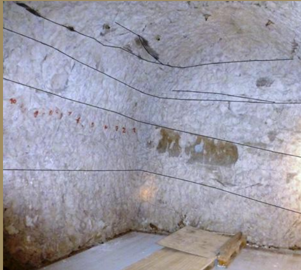
B157 Joints de banc dus à la décompression de la craie - PHT
