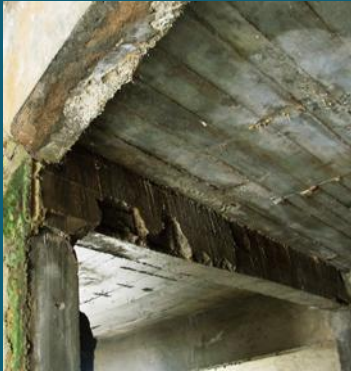
C211 C212 Exemples d'altérations dues à la carbonatation - PHT MG
