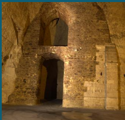
C175 Arcs en maçonnerie de moellons de craie - MG
