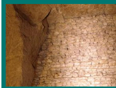
Moellons bruts assisés
