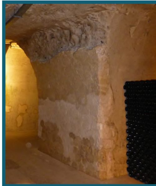
C209 C210 Cas préoccupants : chutes de blocs suite à l'usure mécanique du passage des palettes - PHT
