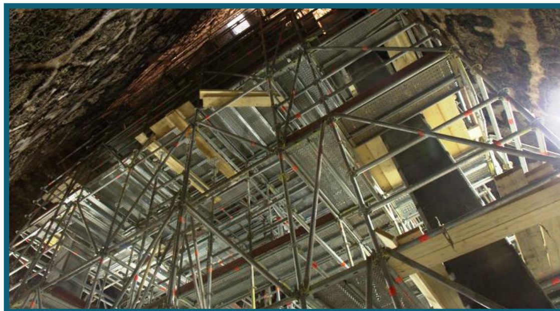
C177Bis Échafaudages pour le coffrage de piliers en béton armé - PHT
