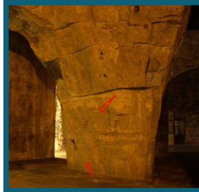
C209 C210 Cas préoccupants : chutes de blocs suite à l'usure mécanique du passage des palettes - PHT
