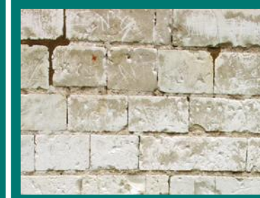
Carreaux en assises régulières à joints vifs
