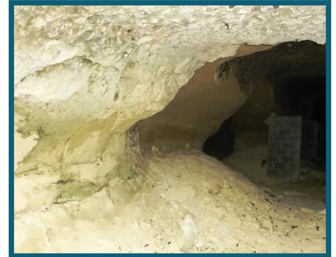
C200 C200bis Erosion de la base des piliers d'une carrière de calcaire tendre - PHT
