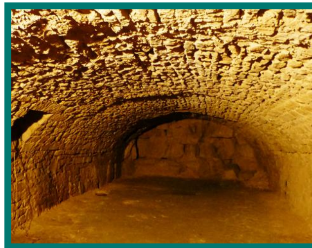
A96Bis Cave maçonnerie en moellons de calcaire des formations du jurassique avec front de taille en fond de cave - PHT
