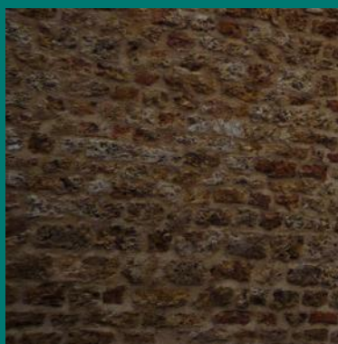
A105 Parements en roche meulière et caves entièrement construites en meulières sur coffrages en bois - MG
