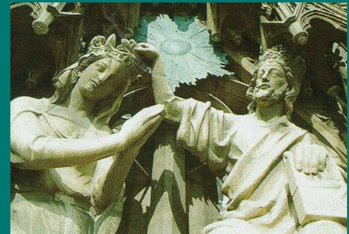
A91Ter Notre Dame de Reims Restauration du portail principal en liais de Courville - PHT
