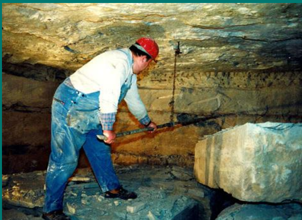
A90 Abattage à la lance à Courville jusqu'en 1970 - PHT
