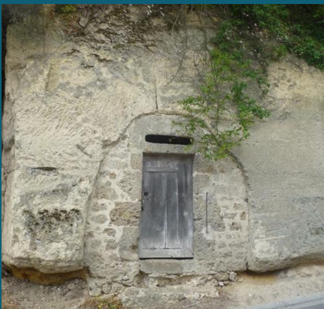
C1712 Conserver les systèmes existants d'aération qui ont fait leurs preuves, impostes, parapluies, etc. - PHT
