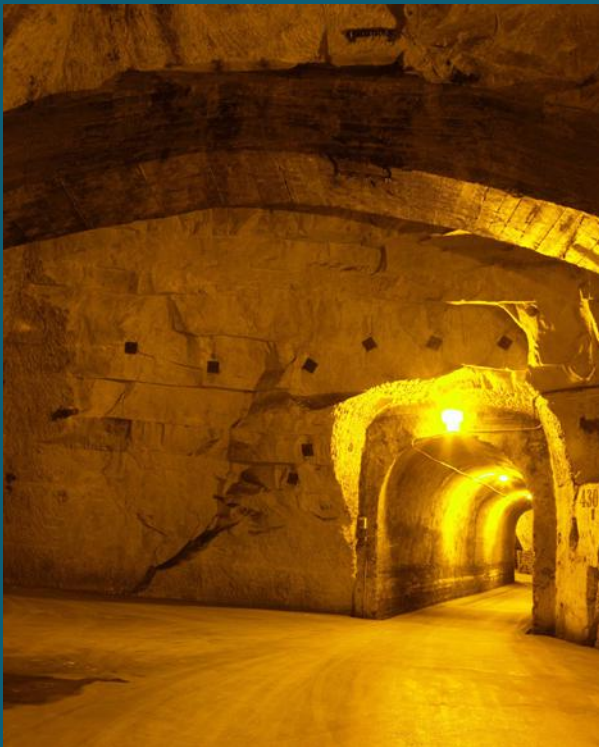
C179 Béton armé et boulonnages sont souvent associés dans les renforts - MG
