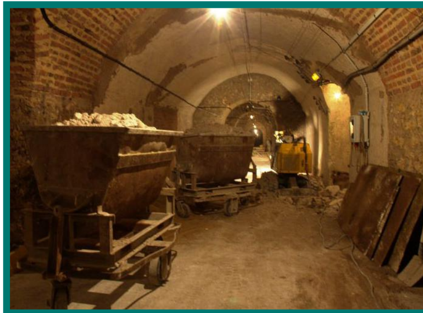
A80Bis Déblaiement en cours... MG
