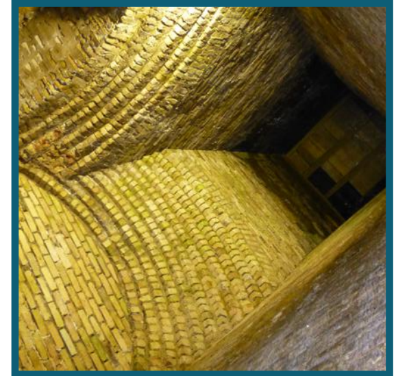
C190Ter Essor entièrement repris en briques pour servir d'assise aux bâtiments de surface -PHT
