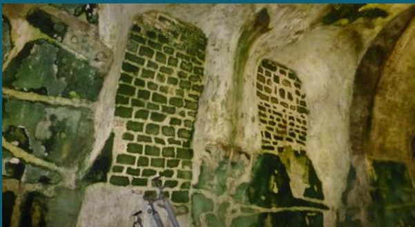
C227 algues vertes en « quadrillage ». Les algues se fixent sur les parties les moins basiques en craie, comme les joints - PHT
