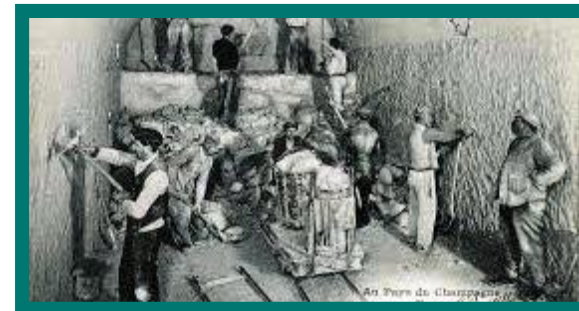
A54 A55 Creusement des caves à Epernay vers 1900, on peut remarquer le fil à plomb directeur dans l'axe de la galerie - UMC
