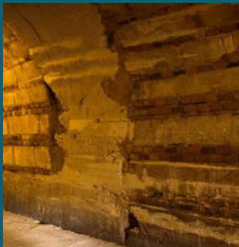
C206 C207 C208 Usure des parois par le passage des palettes - PHT
