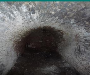
A128 A129 Bars-su- Aube - Effets du manque d'aération des caves et de la condamnation des accès: moisissures et affaissements - PHT
