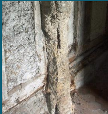
C214 L'humidité à la base - PHT
