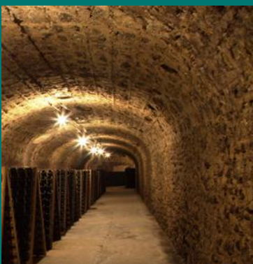
A105 Parements en roche meulière et caves entièrement construites en meulières sur coffrages en bois - MG
