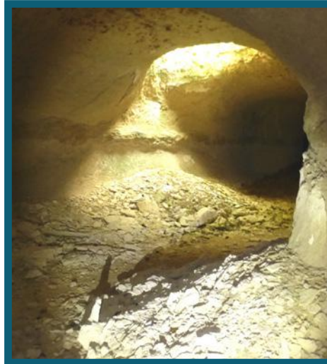
C200 C200bis Erosion de la base des piliers d'une carrière de calcaire tendre - PHT
