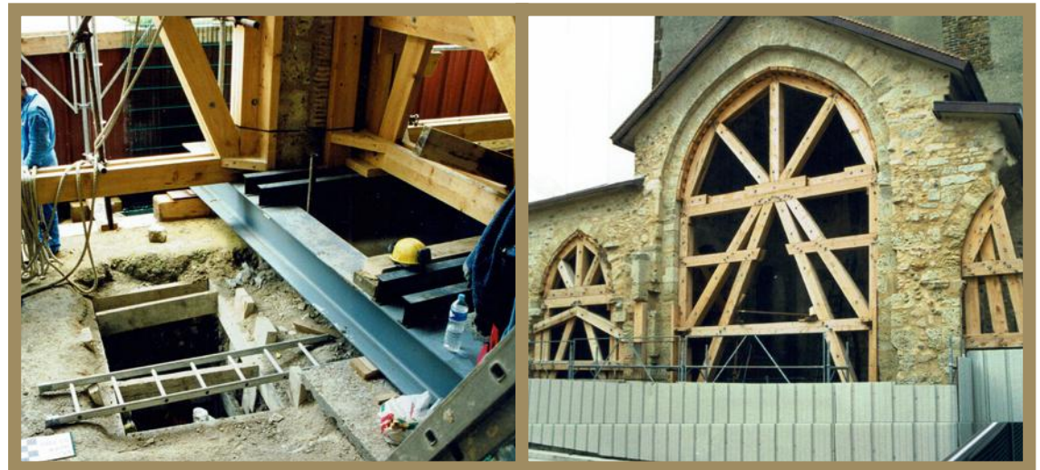
B152 Bis et Ter Etaisement des bâtiments de surface pour la réalisation d'un sondage Archéologique manuel à la main en vue d'une reprise en sous œuvre.
