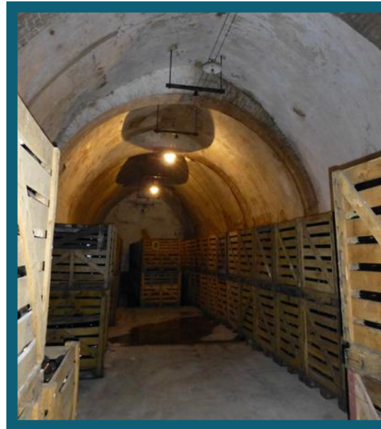
C180 Renforcement par arcs doubleaux - PHT
