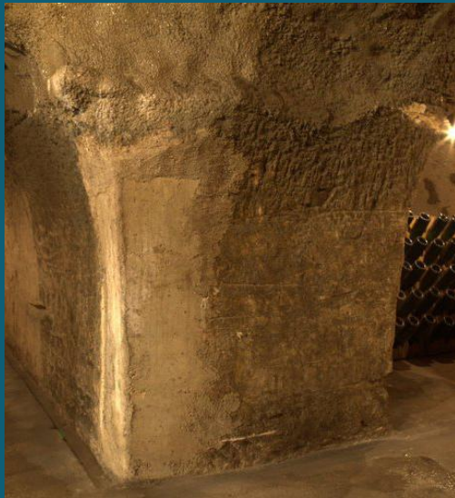
C189 Béton projeté sur une paroi en craie - PHT
