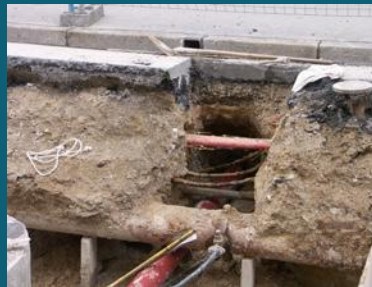
Phase 1 : identification de la cause. Localisation des réseaux existants
