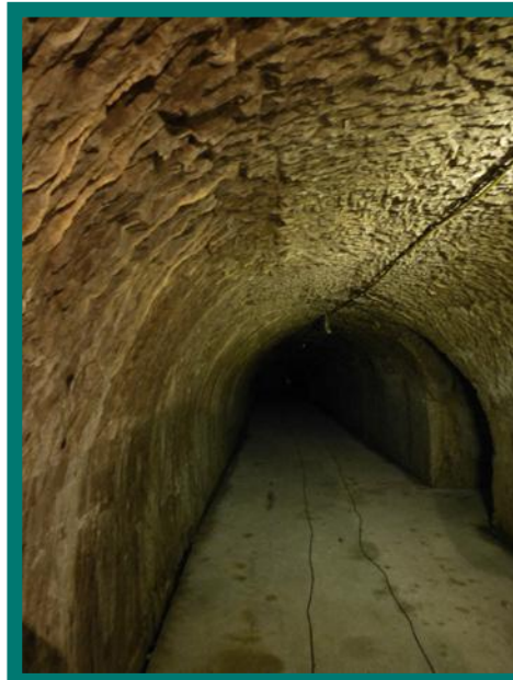
A47 Voûte taillée en berceau plein cintre - PHT
