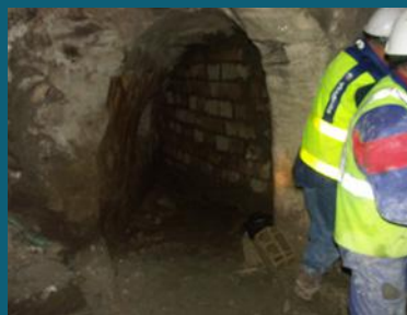
Phase 3: Purgé des sols d'assise du remplissage et construction des murs masques
