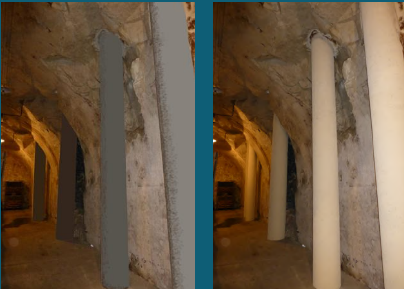
C240 C241 Traitement esthétique des fondations profondes qui traversent une cave - PHT
