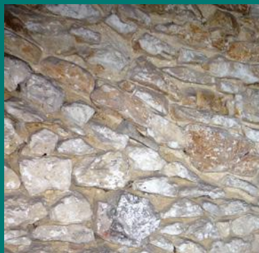
A103 Moellons équarris posés en assises irrégulières - PHT
