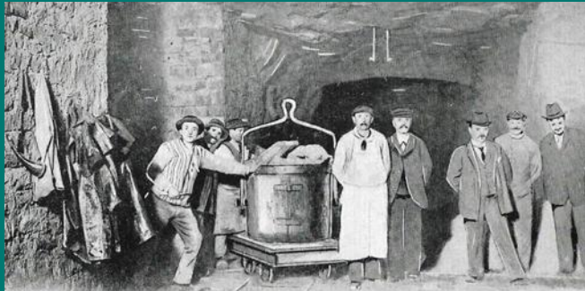
ÉPERNAY — PERCEMENT D'UNE NOUVELLE GALERIE DE CAVES (Collection du Champagne Mercier).
