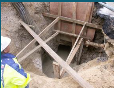
Phase 4: Remplissage avec un coulis adapté ré-excavable par nappes successives après prises de celles-ci
