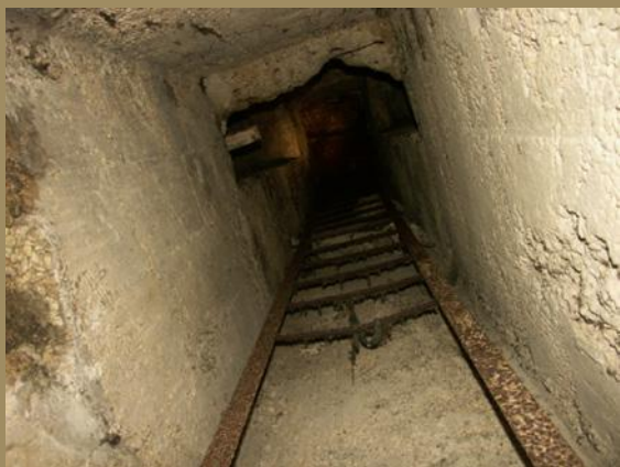
B146 Puits de sortie de secours sous une rue à Reims avec abris - PHT
